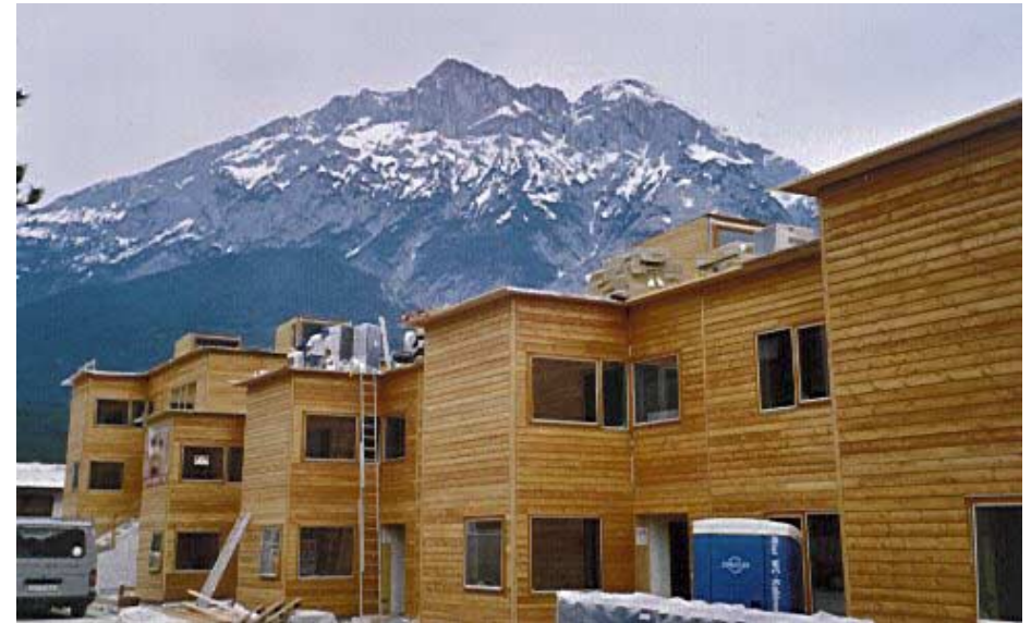
BV Telfs, Österreich, Architekturbüro Riess / Graz
