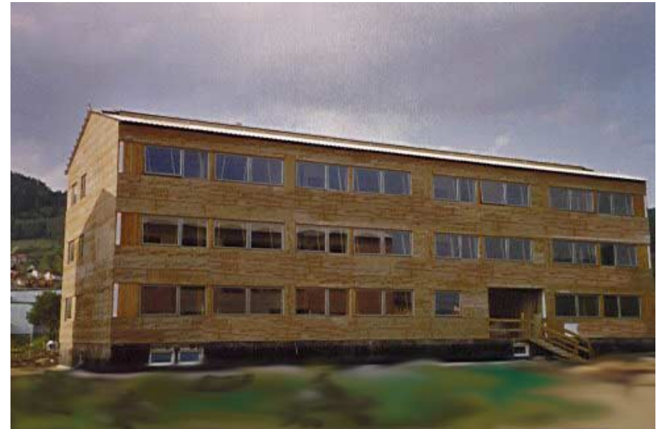
BV Kindberg, Österreich, Architekturbüro Hohensinn / Graz
